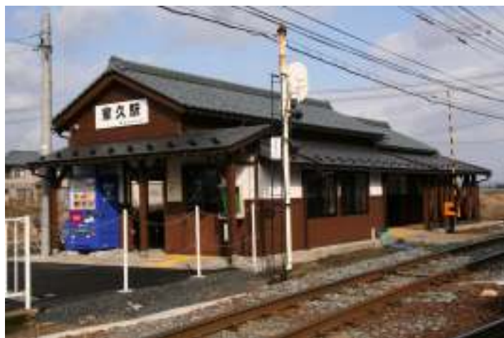
改修された新駅舎（晴天の日に撮影）
