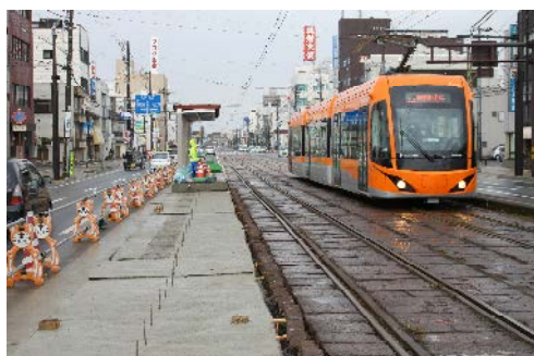
工事の途中の状況
