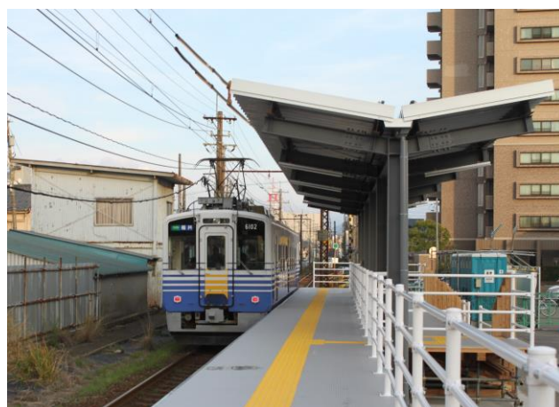
●えち鉄田原町駅／仮設ホーム／撮影 清水
