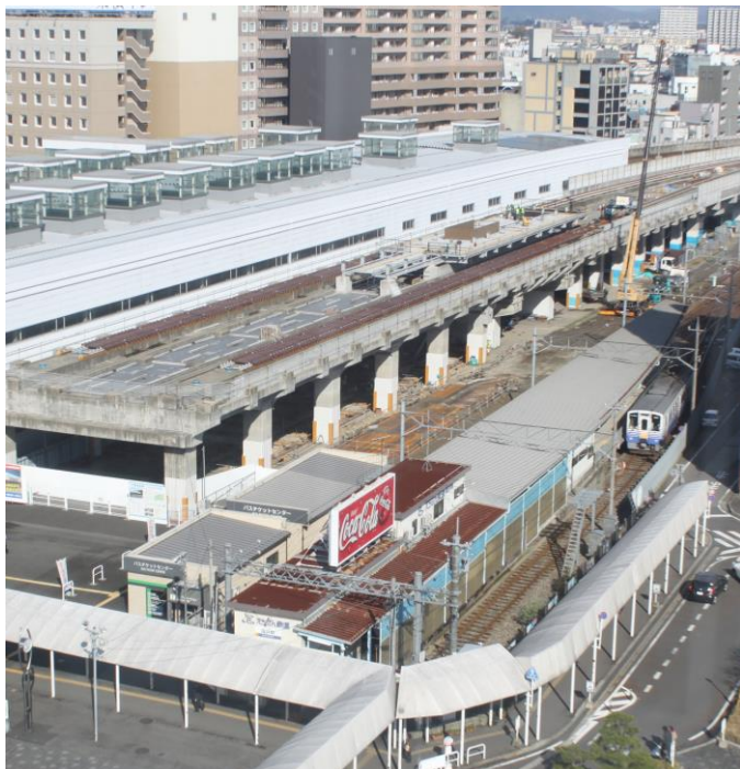
●えち鉄福井駅新幹線高架上仮設駅整備中 撮影／清水
