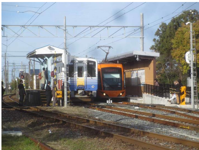
写真4：鷲塚針原駅を見学 右側が折り返し用の低床ホームと FUKURAM、左が高床ホームと鉄道車両 6001 形
