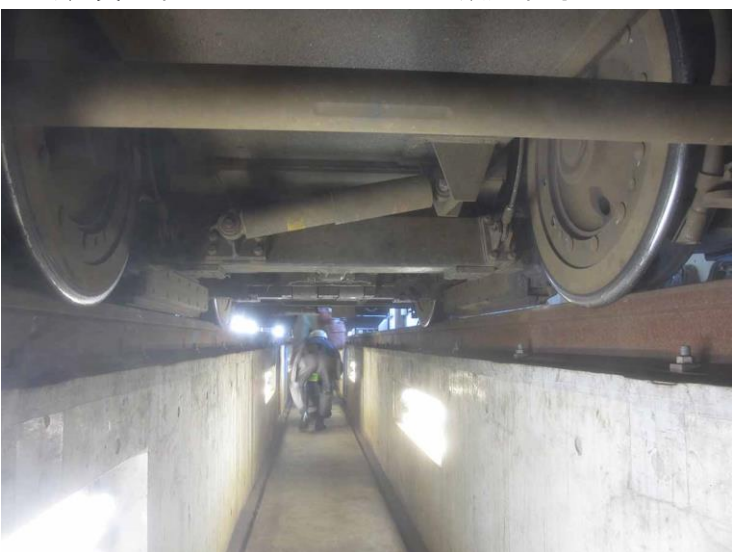
写真3：Ki-boの床下 床を低くするため、車輪と車輪をつなぐ車軸がないことがわかる
