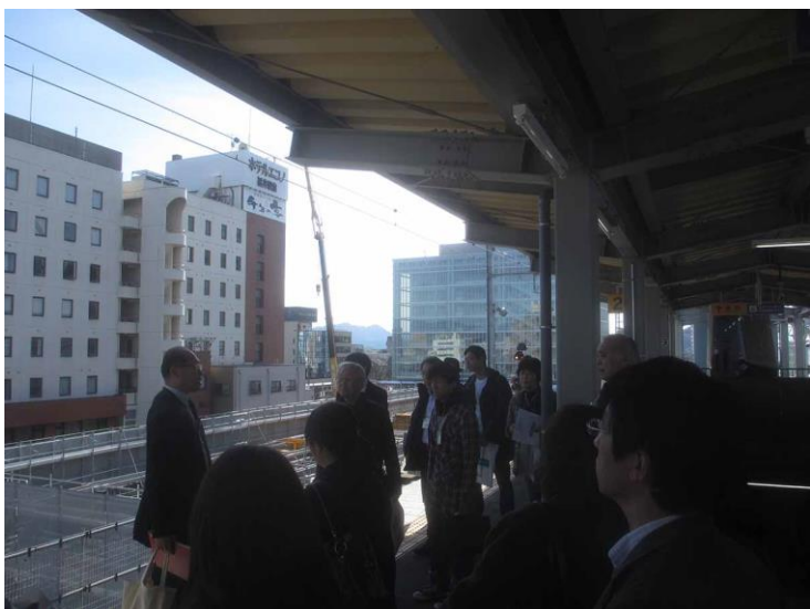
写真1：えちぜん鉄道福井駅での説明 新幹線用高架を利用して運行中、奥が工事中のえちぜん鉄道の高架部分
