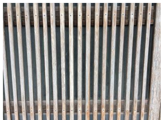
▲昭和の頃の千本格子 (格子の幅が全体的に不均一になっている)
