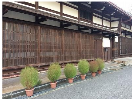
▲昭和以前の建物 (厚板葺で分かる)
