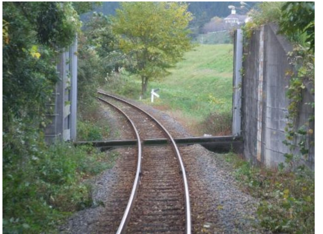
珍しい洪水時に締め切る門
