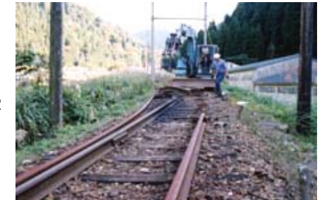
重機によるレール撤去作業 = 市野々～永平寺 03.10.18
