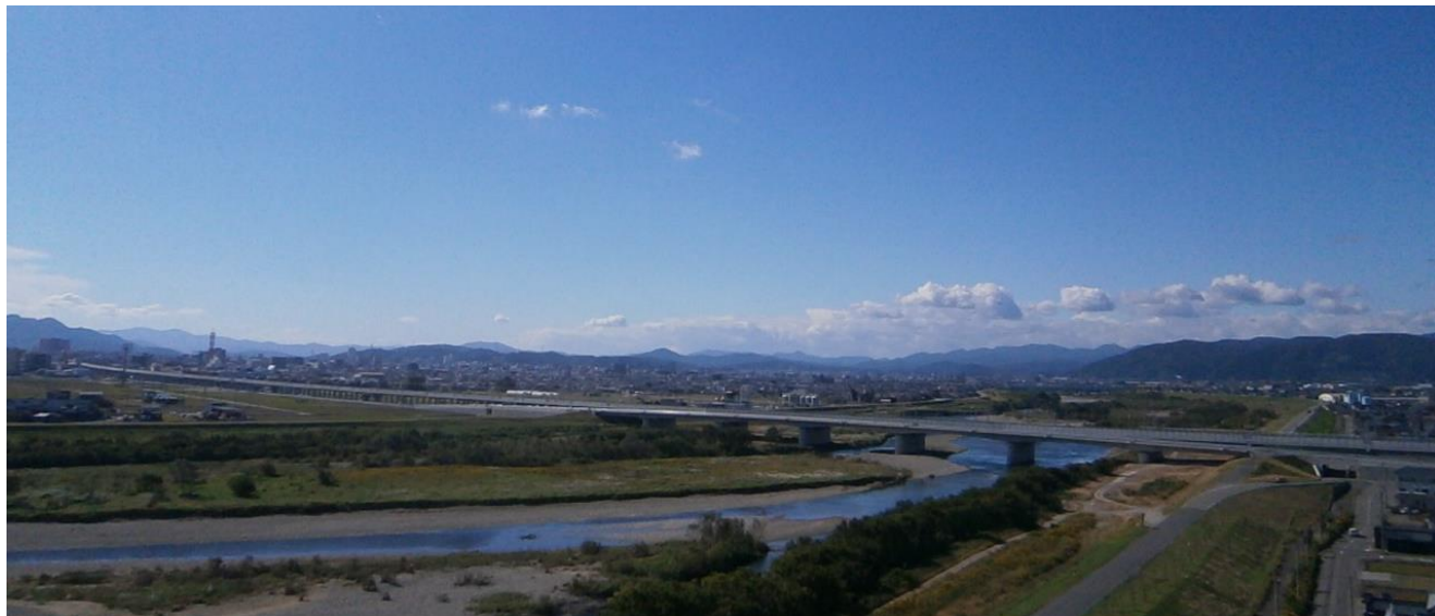
撮影：変集長 撮影場所：マイアクア（給水塔）屋上<福井市>
