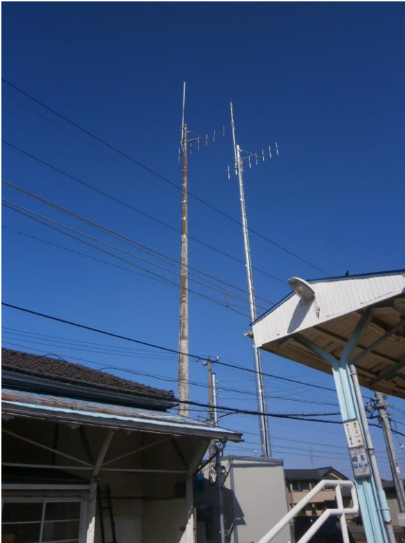
撮影：変集長 20230306@えち鉄鷲塚針原駅 *業務用無線アンテナ新旧交代
